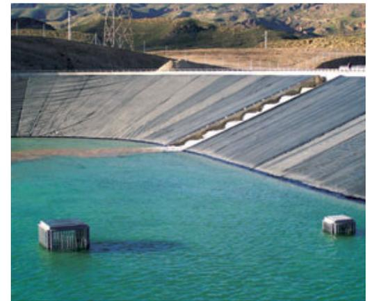
Fotografía 43. Material impermeabilizante de balsa de riego
