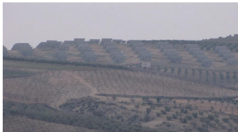
Fotografías 74 y 75. Emplazamiento en relanos de ladera y estructuras perpendiculares a la pendiente. Archidona, Málaga, y La Mala, Granada. Instalaciones FV 16/42
