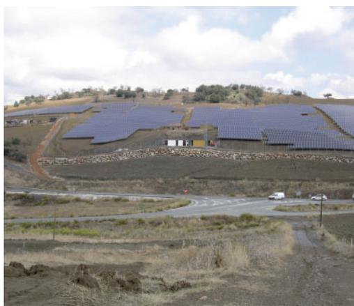
Fotografías 103 y 104. Disposición de las hileras paralelas a las curvas de nivel y tratamiento de taludes con bloques ciclópeos. Lucainena de las Torres, Almería y Casabermeja, Málaga. Instalaciones FV 32/20
