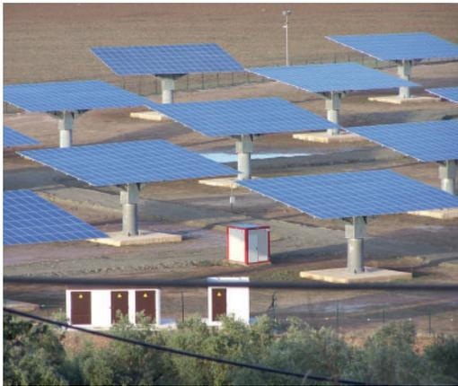
Fotografías 164 y 165. Base de hormigón en seguidores aislados. Archidona, Málaga, y Andújar, Jaén. Instalación FV 8/24
