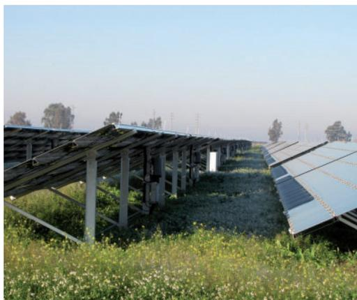
Fotografía 198. Cubierta vegetal para suelo de estructuras. Los Palacios, Sevilla. Instalación FV 69
