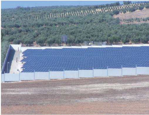
Fotografías 113 y 114. Vallado de hormigón y mallas verdes opacas sobre cerramientos. Puente Genil, Córdoba, y Ardales, Málaga. Instalaciones FV 14/03
