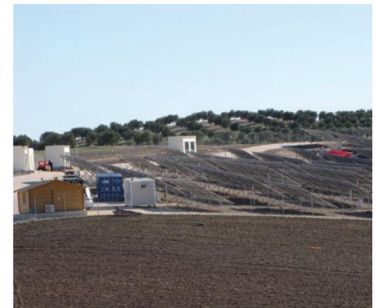
Fotografías 170 y 171. Instalaciones técnicas auxiliares: transformadores y convertidores con alojamiento auxiliar de madera. Alcaudete, Jaén, y Osuna, Sevilla. Instalaciones FV 23/27
