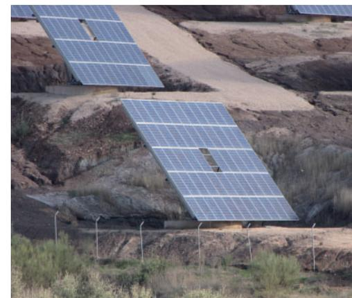
Fotografías 161 y 162. Instalaciones de seguidores aislados con paneles discontinuos y continuos. Vejer, Cádiz, y Archidona, Málaga. Instalaciones FV 88/8
