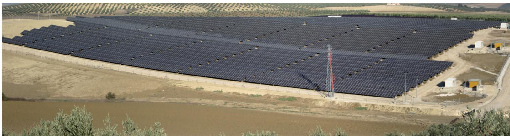
Fotografía 189. Contraste entre el material utilizado en los viales internos y externos de alto albedo en comparación con el material fotoeléctrico y el terreno original. Instalación continua en hileras en Baena, Córdoba. Instalación FV 22
