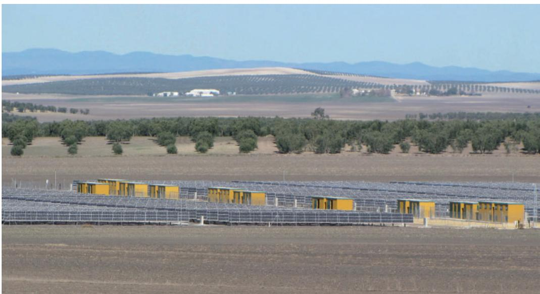
Fotografía 175. Transformadores de tipología estandarizada. Paradas, Sevilla. Instalación FV 28
