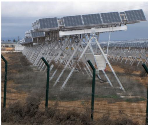
Fotografías 146 y 147. Instalaciones en hilera con seguimiento a dos ejes y a uno respectivamente. Darro, Granada, y Los Barrios, Cádiz. Instalaciones FV 43/86
