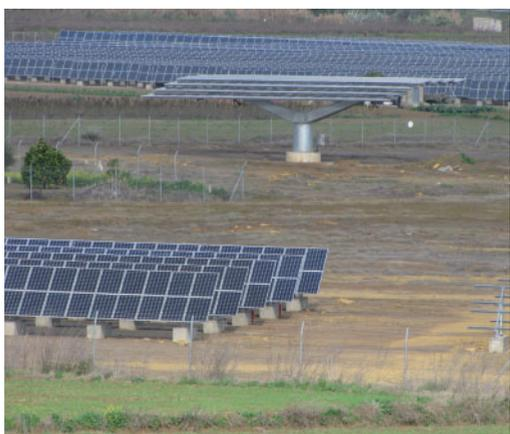
Fotografía 159. Mezcla de tipología de estructuras. Manzanilla, Huelva. Instalación FV 52
