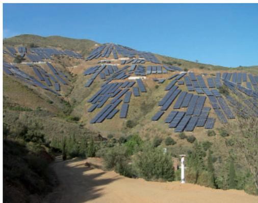
Fotografías 97 y 98. Instalaciones de hileras continuas con disposición en líneas de mínima y máxima pendiente. Lucainena de las Torres, Almería y Moclinejo, Málaga. Instalaciones FV 32/10
