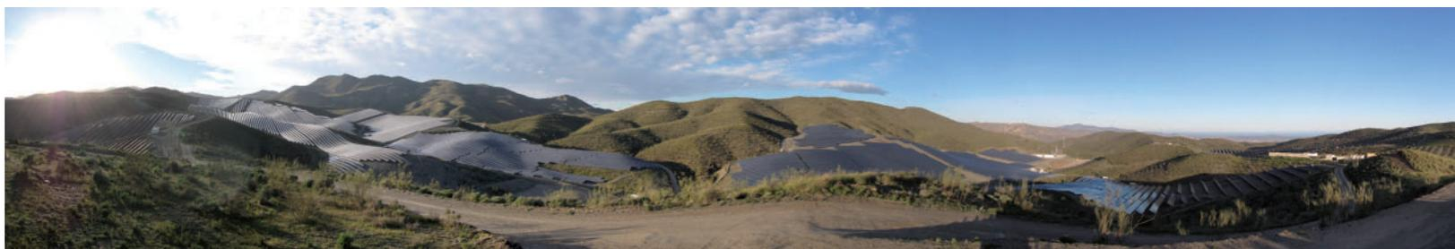
Fotografía 96. Instalación de hileras continuas siguiendo la topografía del terreno. Lucainena de las Torres, Almería. Instalación FV 32
