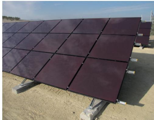
Fotografías 132 y 133. Utilización de estructura blanca con módulos de silicio multicristalino y oculta con silicio amorfo. Plantas fotovoltaicas de Paradas y Carmona, Sevilla. Instalaciones FV 29/44
