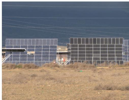
Fotografías 121 y 122. Módulos de silicio amorfo y combinación de módulos mono y multicristalino en el mismo panel. Huéscar y Dólar, Granada. Instalaciones FV 83/35
