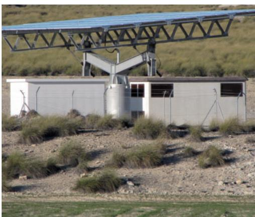
Fotografías 148 y 149. Instalaciones con seguidores de mástil. Benamaurel, Granada, y Linares, Jaén. Instalaciones FV 82/79
