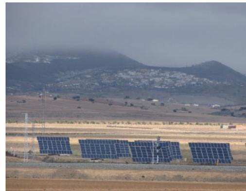
Fotografías 125 y 126. Disposición apaisada de módulos y alternancia de módulos horizontales y verticales. Cúllar y La Calahorra, Granada. Instalaciones FV 81/37
