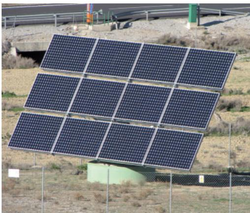
Fotografías 150 y 151. Instalaciones con seguidores de plataforma. Cúllar y Pinos Puente, Granada. Instalaciones FV 81/21
