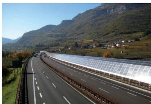
Fotografía 54. Paneles fotovoltaicos en autopista de Brennero (Italia)
