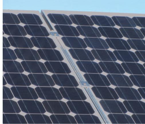
Fotografía 123. Módulos de silicio monocristalino original y con tratamiento del fondo del módulo para disminuir el contraste. Alcaudete, Jaén. Instalación FV 23
