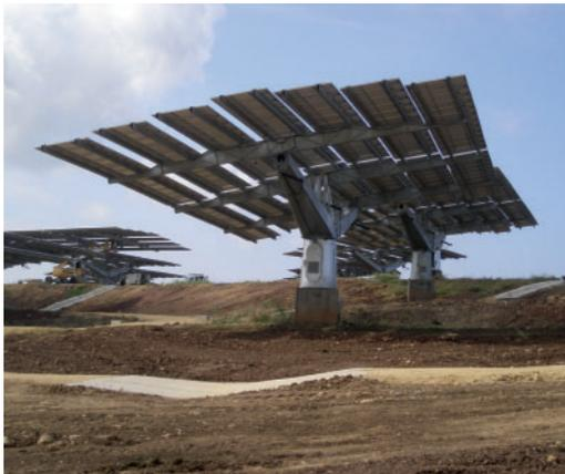
Fotografías 155 y 156. Separación de los paneles en seguidores de mástil y paneles con hueco central Vejér, Cádiz, y Puente de Génave, Jaén. Instalaciones FV 88/80
