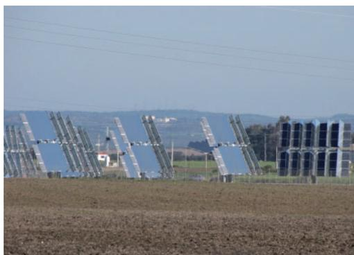
Fotografía 152. Seguidores de concentración con espejos. Sanlúcar la Mayor, Sevilla. Instalación FV 66
