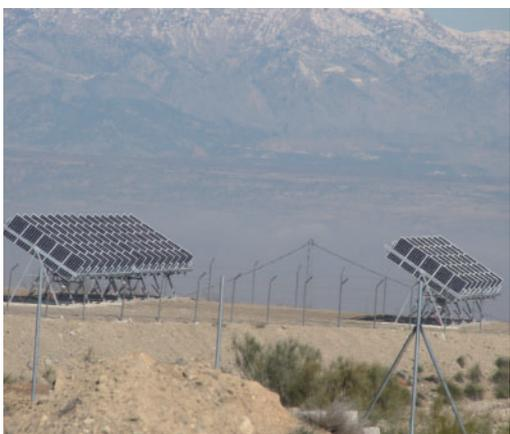
Fotografías 157 y 158. Paneles en estructura de persiana veneciana. Caniles, Granada. Instalación FV 84
