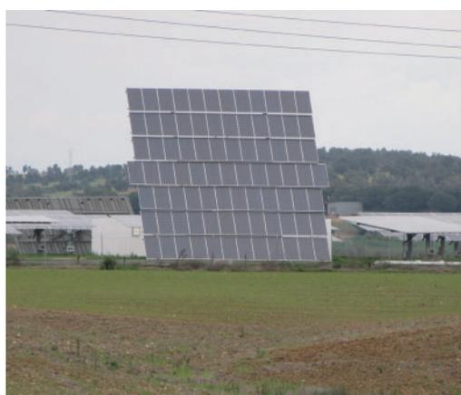
Fotografía 163. Paneles con alineación de módulos irregular. Beas, Huelva. Instalación FV 64
