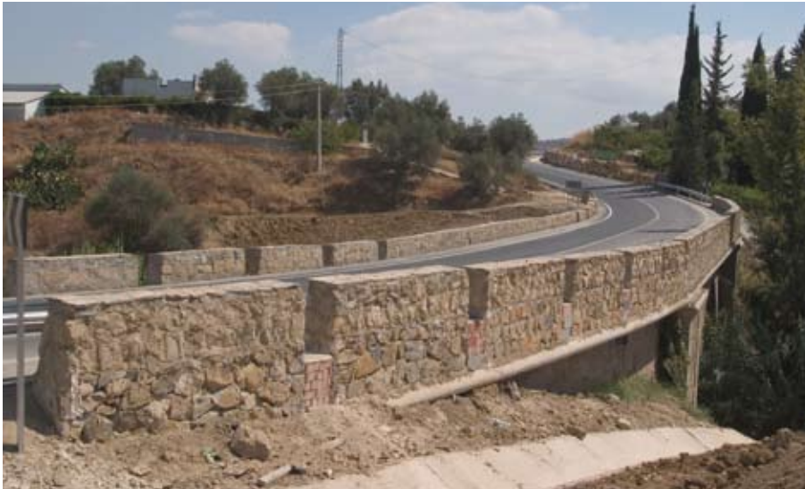
La barrera flexible ha sido sustituida en el viaducto por un pretil almenado rígido.
