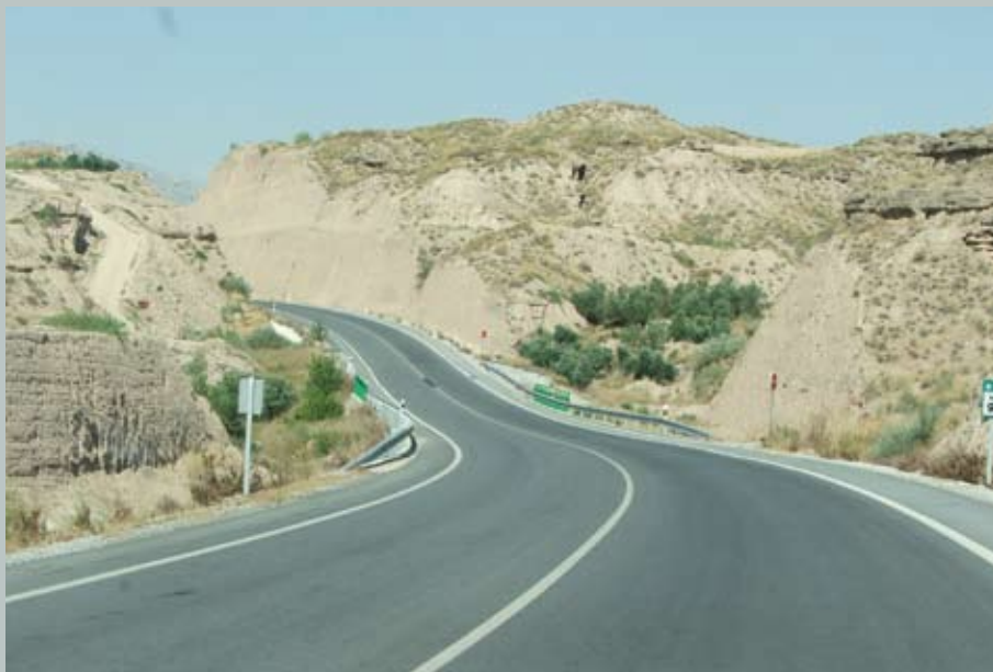
Trinchera de la A-315.
