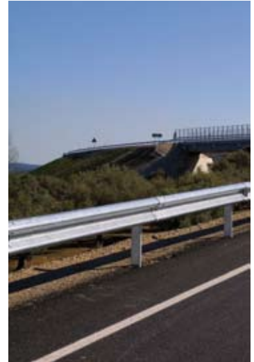
Barrera de contención flexible (bionda) con su característico perfil ondulado, marcadamente geométrico, y notorio brillo metálico.
