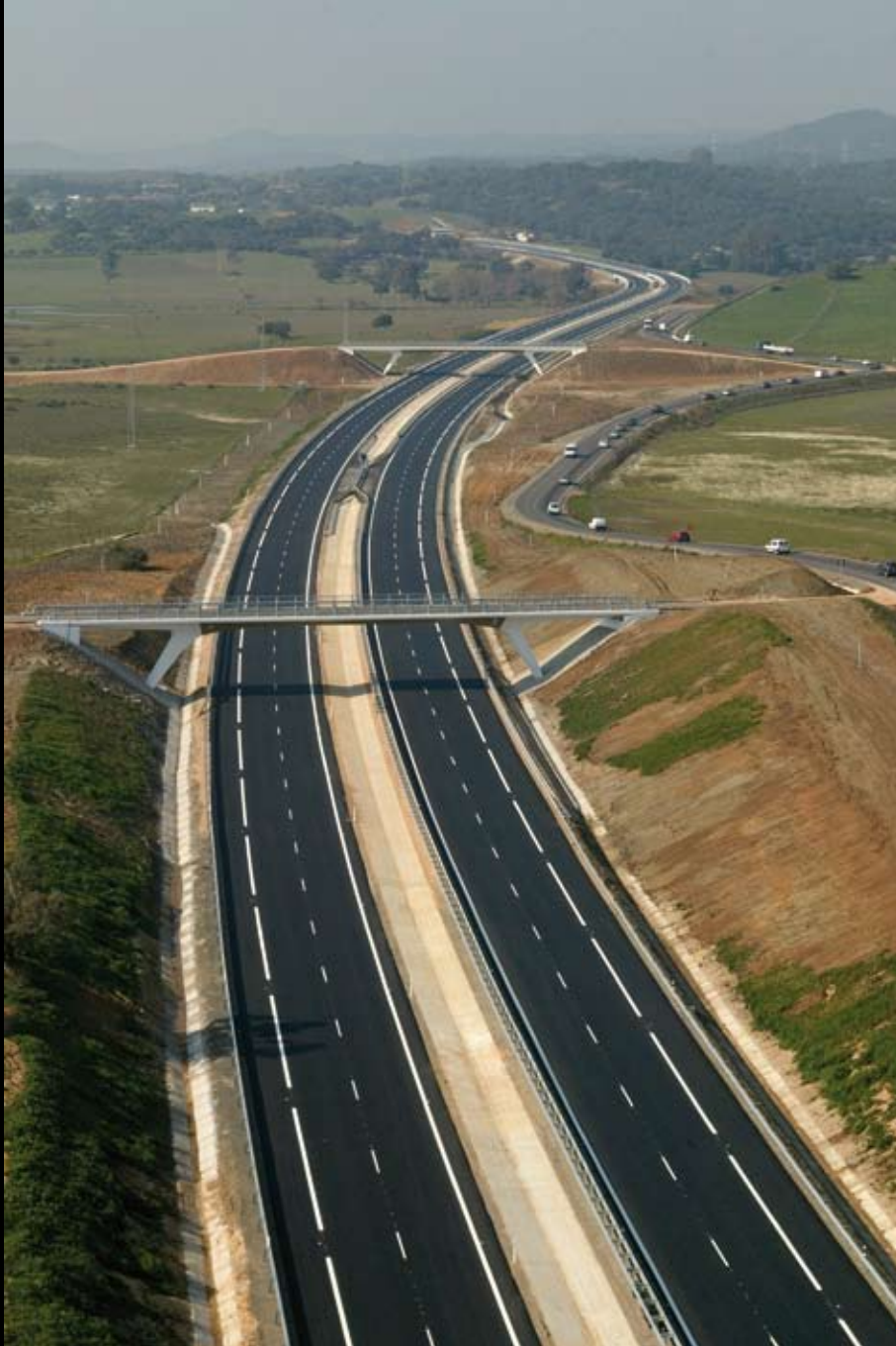
A-381 Jerez-Los Barrios (Cádiz). Los puentes, ya sean transversales para pasos superiores o de soporte de la plataforma, son elementos claves del paisaje de la carretera tanto porque definen la escena, con su diseño como por su efecto en el paisaje exterior.
