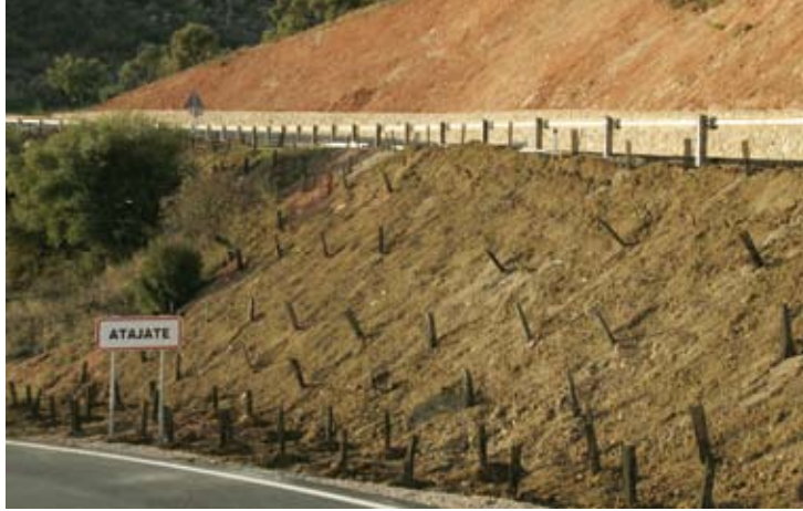
Plantaciones en talud vertical. La revegetación, además de la mejora paisajística, es un método eficaz para estabilizar laderas y protegerlas frente a la erosión.
