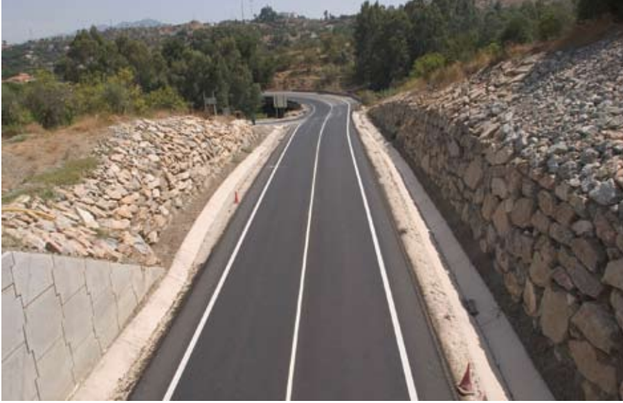
Los muros de contención de piezas prefabricadas (esquina inferior izquierda de la imagen) contrastan con acabados más naturales, como el muro de escollera de la parte derecha y el acabado del desmonte en la izquierda.
