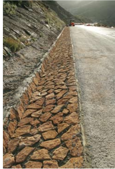
Cuneta revestida con encachado de piedra. Es una alternativa que se integra mejor en el entorno que la cuneta revestida de hormigón o elementos prefabricados.
