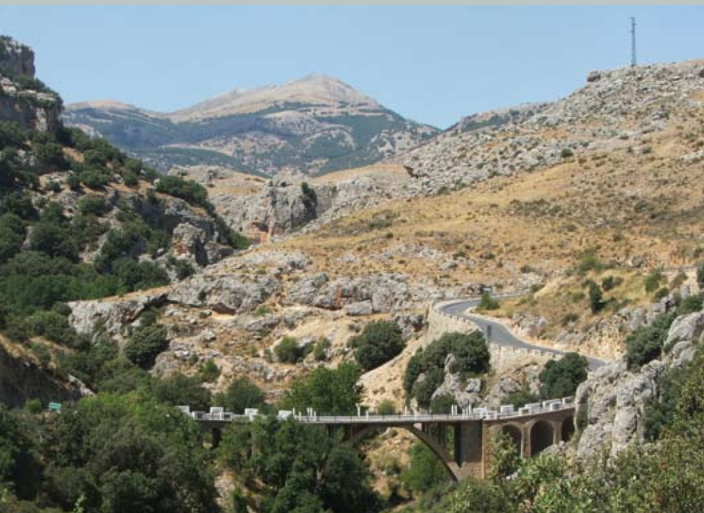
Puente de la A-317.
