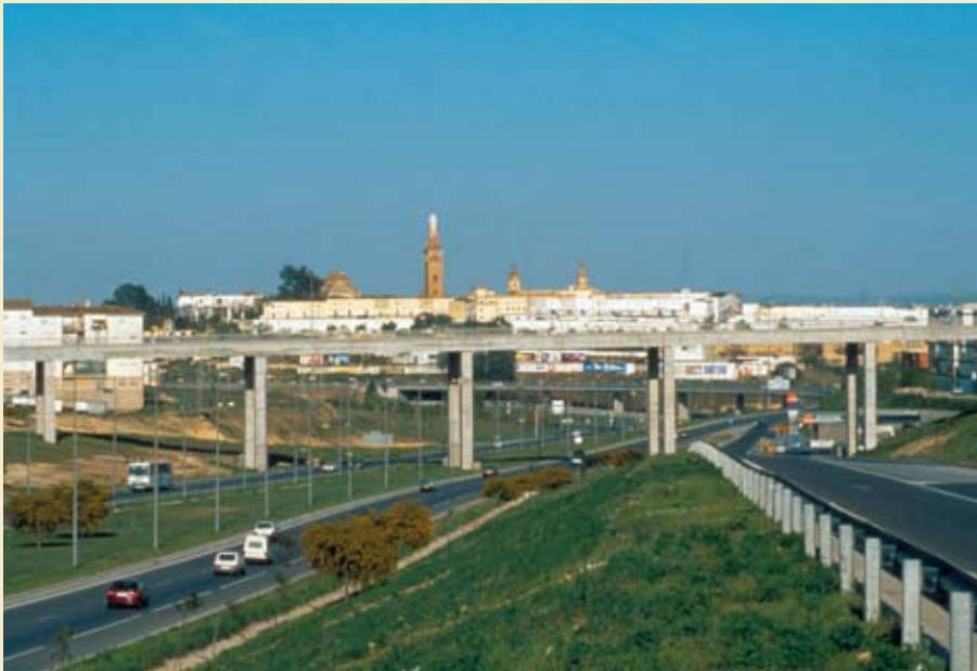
Carretera de acceso al Aljarafe y viaducto de conexión transversal, 1994.
