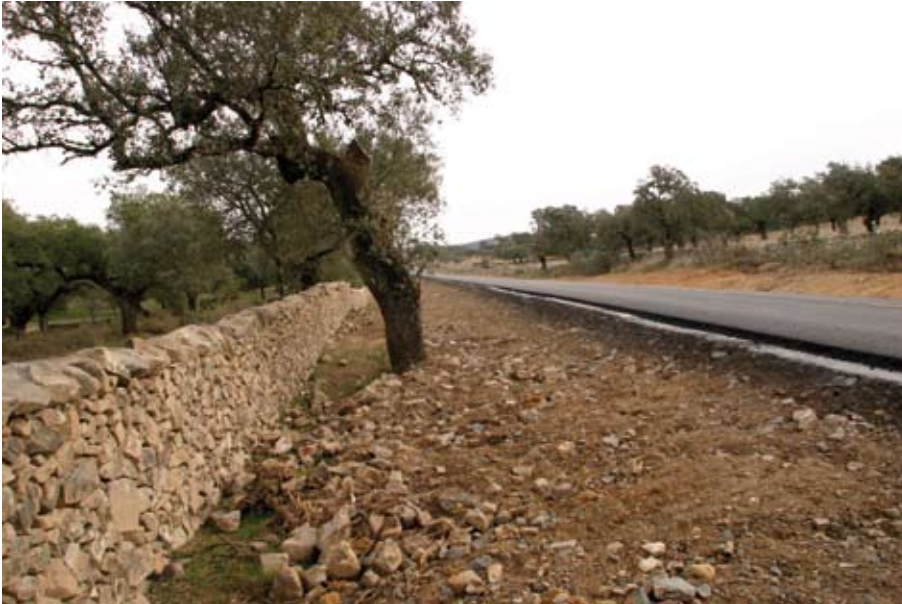
Muro de piedra seca en el límite de una finca. La imitación de estos referentes del carácter en la realización de elementos de contención dotará de identidad a la infraestructura.
