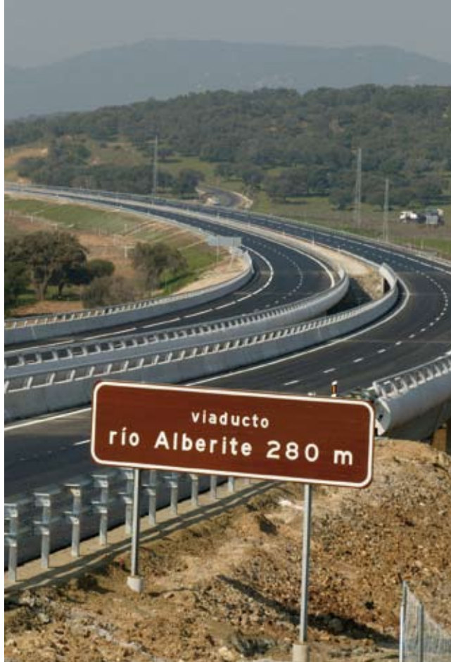
A-381, Jerez-Los Barrios (Cádiz). La capacidad que las carreteras tienen de mostrar el paisaje, explicarlo y promover su disfrute y entendimiento puede ser mejorada con la instalación de señalización temática, miradores, centros de interpretación y otras medidas.
