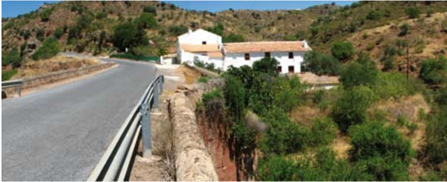
Área lateral en la A-7075 tras el cruce del río Campanillas (en primer término de la foto, el puente, pretil y barrera de seguridad), en el término municipal de Almogía (Málaga).
