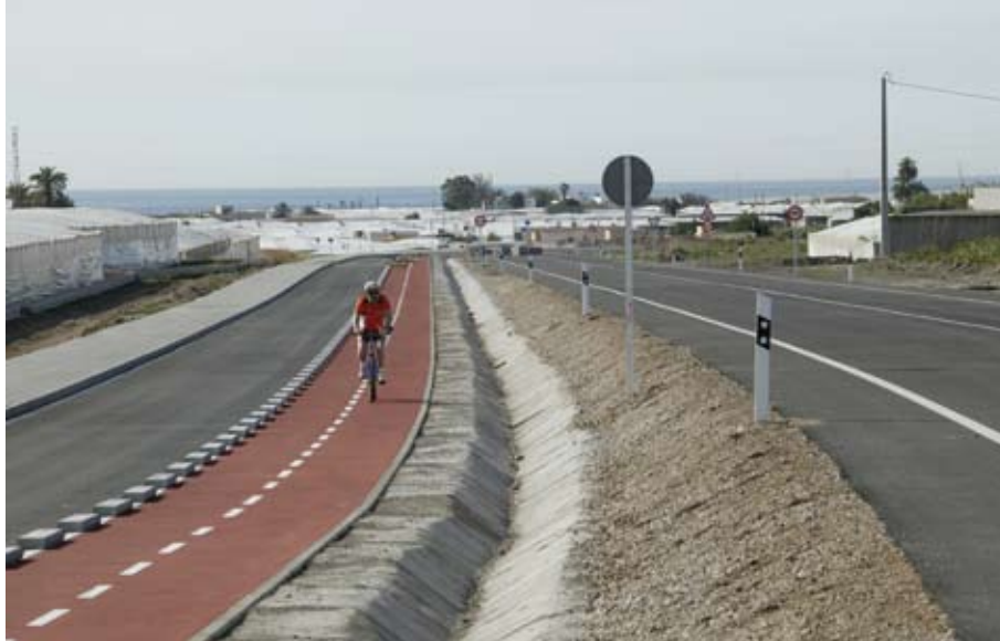
Carril bici con separación total del tráfico. Se ha separado el tronco principal de la vía del carril de uso ciclista y se ha protegido éste último de una vía auxiliar mediante una hilera discontinua de bordillos. El tráfico peatonal se ha canalizado por una acera (en el extremo izquierdo de la imagen).
