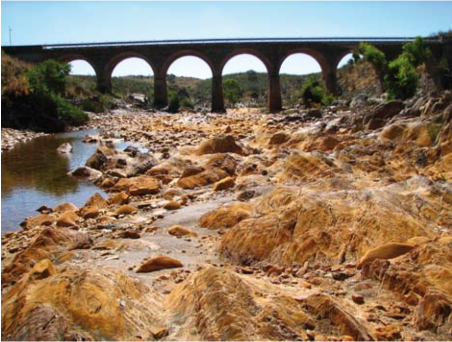
Viaducto de la A-475 sobre el río Oraque, en el límite municipal entre las localidades de Calañas y Villanueva de las Cruces, en el Andévalo onubense. El río muestra tonalidades típicas de la mayor parte de la red hídrica de esta zona de la provincia de Huelva. El puente cierra con efecto geométrico la escena de este singular paisaje fluvial.
