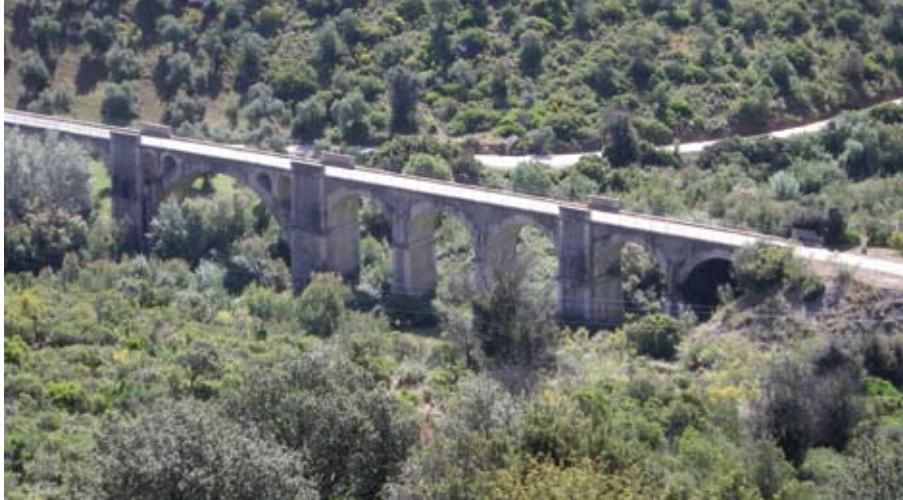
Viaducto en la A-8126 sobre el río Guadalporcún, en el término municipal de Coripe, en la campiña sur de Sevilla.
