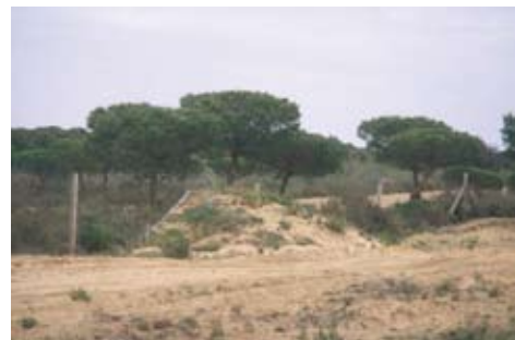
Rampa de salida para animales. El tratamiento de integración ambiental de la carretera incluye diversos dispositivos que permiten su convivencia y compatibilidad con los procesos del medio.
