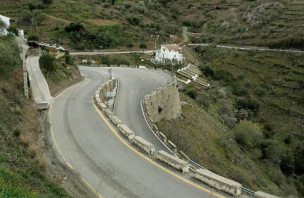
Barrera de contención rígida que evita que los vehículos puedan salirse fuera de la plataforma. Es una solución para carreteras de bajas prestaciones (carreteras de montaña, vecinales, rurales).
