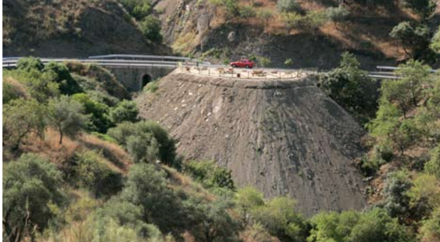
Vertedero de tierras al lado de la traza de la carretera acondicionado en su parte superior como merendero. El tratamiento de su superficie lateral y de la revegetación debe cuidarse.
