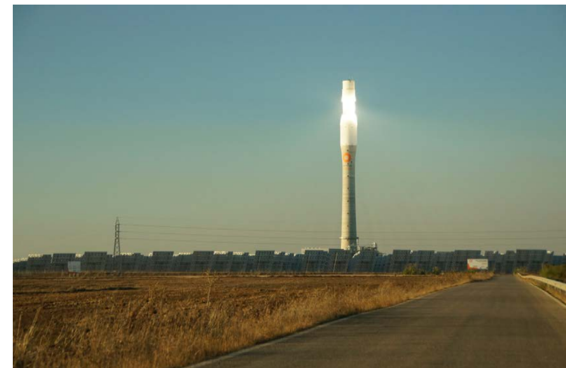
Imagen 99: Planta solar Gemasolar. Autor: Rafael Medina Borrego.
