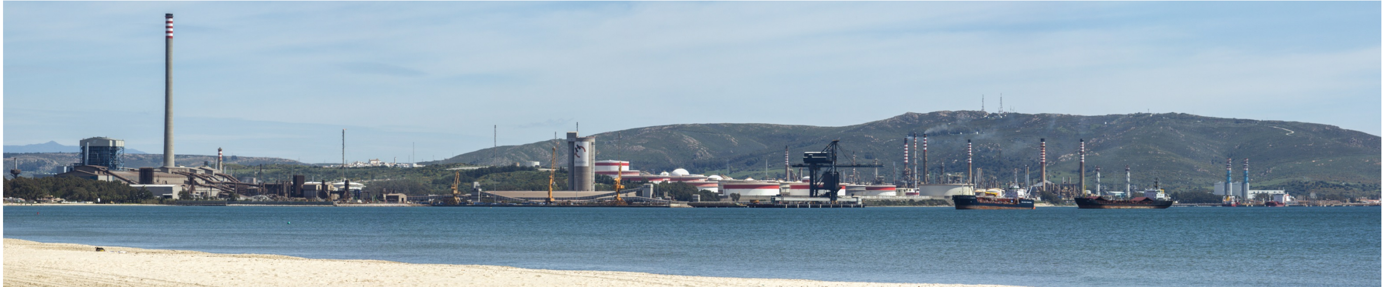
Foto 229. Sector de la Bahía de Algeciras correspondiente a los términos municipales de Los Barrios y San Roque, donde se asientan las industrias pesadas, entre otras, de Acerinox, la refinería de Cepsa y dos centrales térmicas de generación de electricidad. Autor: Antonio Ramírez Ramírez.
