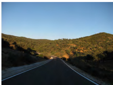
Foto 1: La vertiente sureña del Guadiato, en su tramo alto, va acompañada de densas dehesas.
