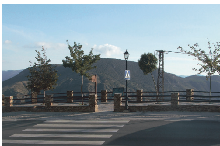
En algunos miradores, como éste localizado en Pórtugos, torres y cables de tendidos eléctricos se interponen en la proyección visual.
