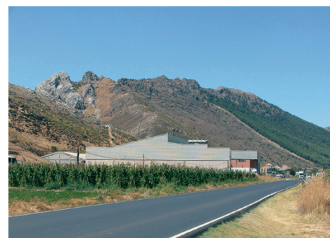
Naves industriales y agrarias, junto a viviendas de diversas tipologías, se aglomeran junto a la carretera entre los Pks. 42'5 y 44'5.
