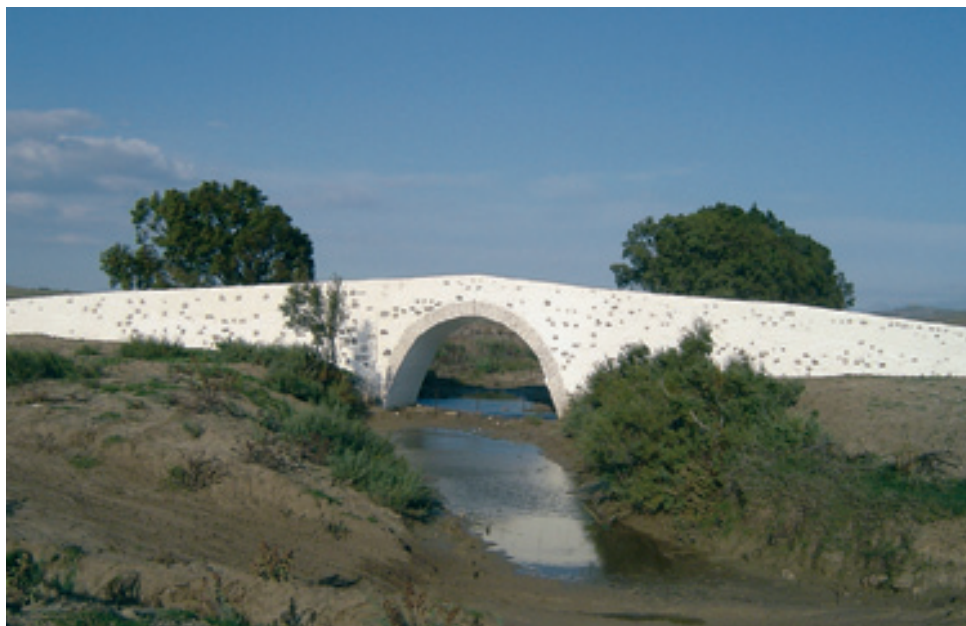
Puente de origen romano en la Cañada eal de Algeciras.
