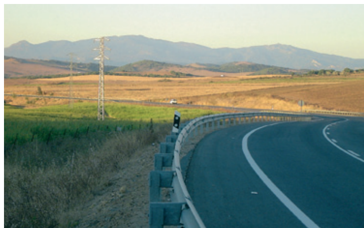
Los tendidos eléctricos suponen un importante impacto visual.
