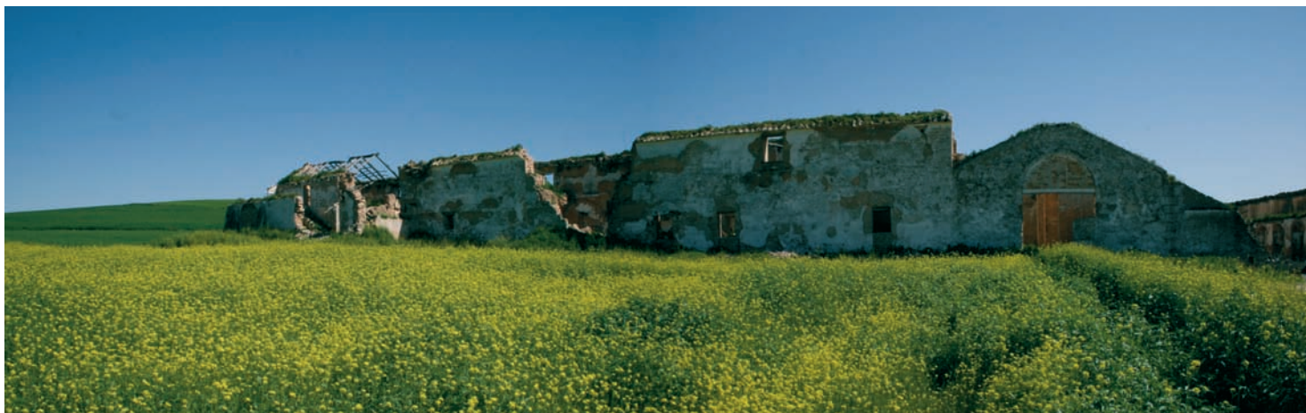
Antiguo cortijo de Fuentidueñas, en las cercanías de la A-388.
