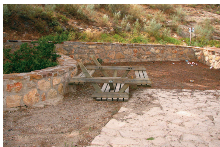
Ejemplo de falta de mantenimiento. Mirador de El Pino.
