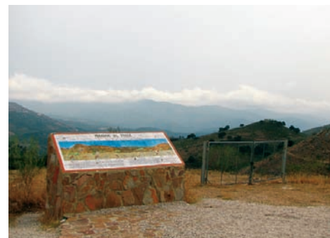
Problemas de integración del vallado en el mirador del Fraile.
