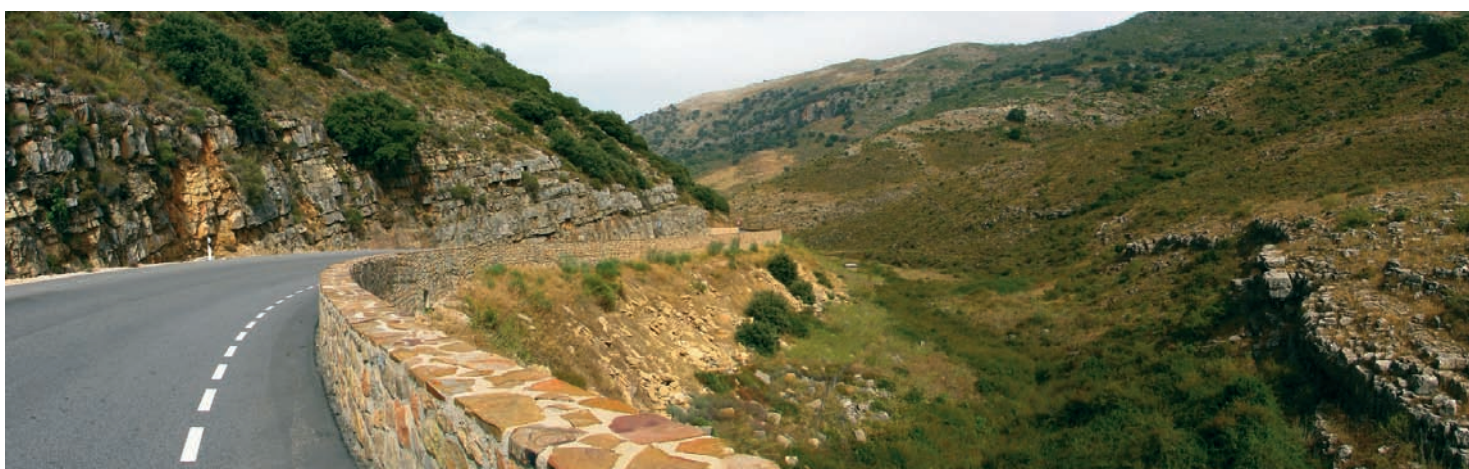
Tramo encajado antes de adentrarse en el valle del Genal.
