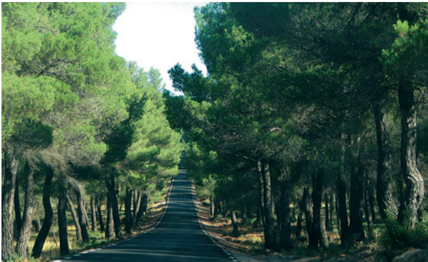
Algunos tramos de la carretera discurren bajo la sombra y el cierre visual ejercidos por pinares maduros (estribaciones de Sierra de María).
