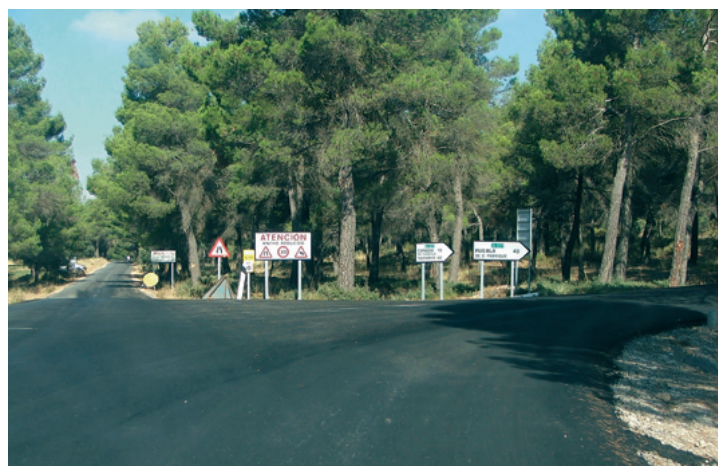
Exceso de señales, indicadores y carteles de estilo heterogéneo en el cruce con la carretera AL-9101.
