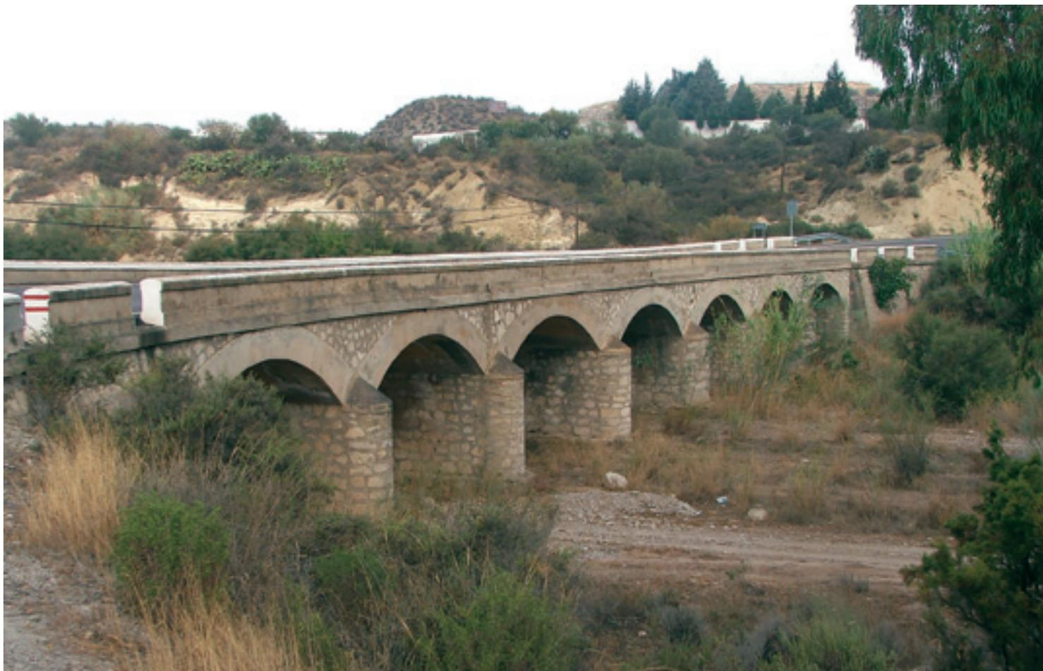
Puente de siete vanos construido en hormigón y mampuestos.
